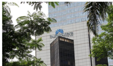
Gedung Bumiputera. (Foto: Dok. Bumiputera)
